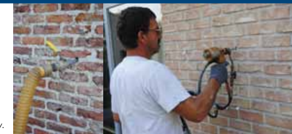
Isolatie inspuiten in de spouw.
