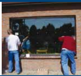
Vervanging van enkel glas door hoogrendementsglas.
