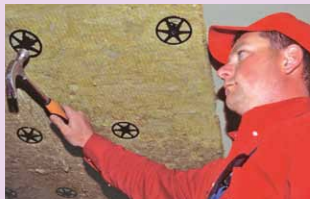
Isolation sous la dalle portante
