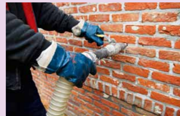
Post-isolation de murs creux.
