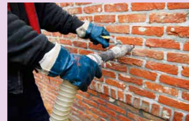
Na-isoleren van spouwmuren.
