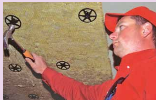
Isolatie onder de draagvloer.
