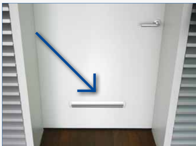
Circulation d'air par une grille dans la porte
