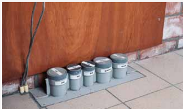
Ouvertures d'accès du coude de raccordement dans l'habitation
