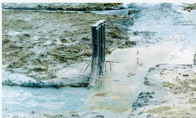
Coude de raccordement dans les fondations en pleine terre
