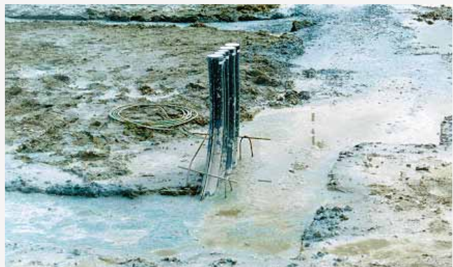
Aansluitbocht in fundering in volle grond
