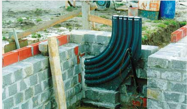
Aansluitbocht in fundering met kruipruimte
