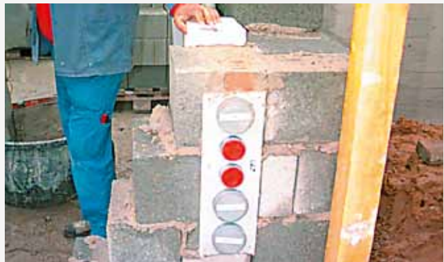
Toegangsopeningen van de aansluitbocht in funderingsmuur
